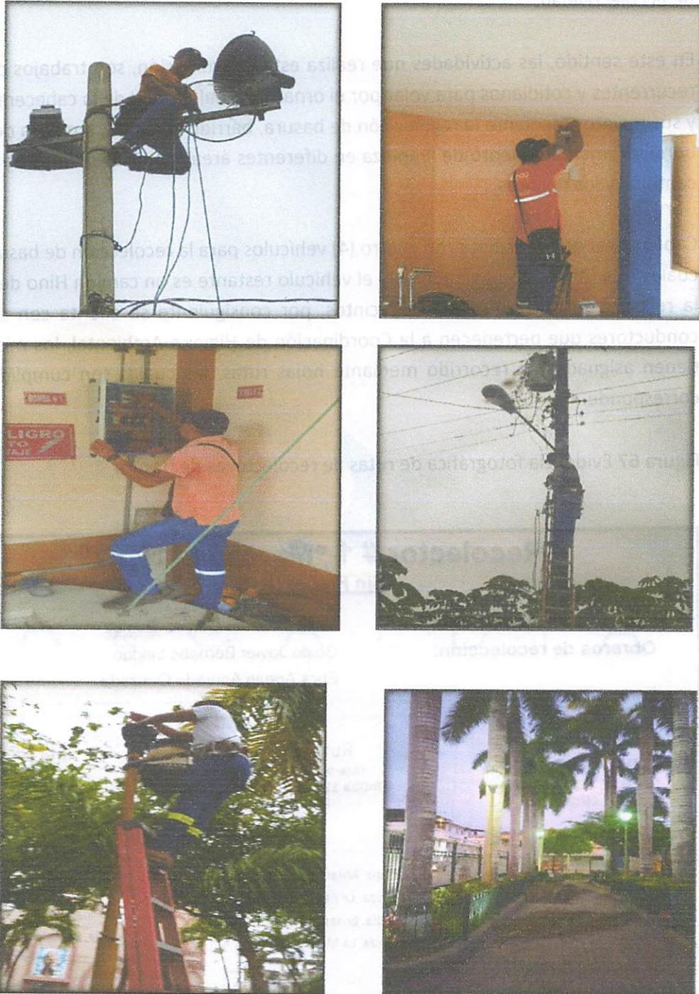
Figura 66 Evidencia fotográfica de mantenimiento de instalaciones eléctricas
