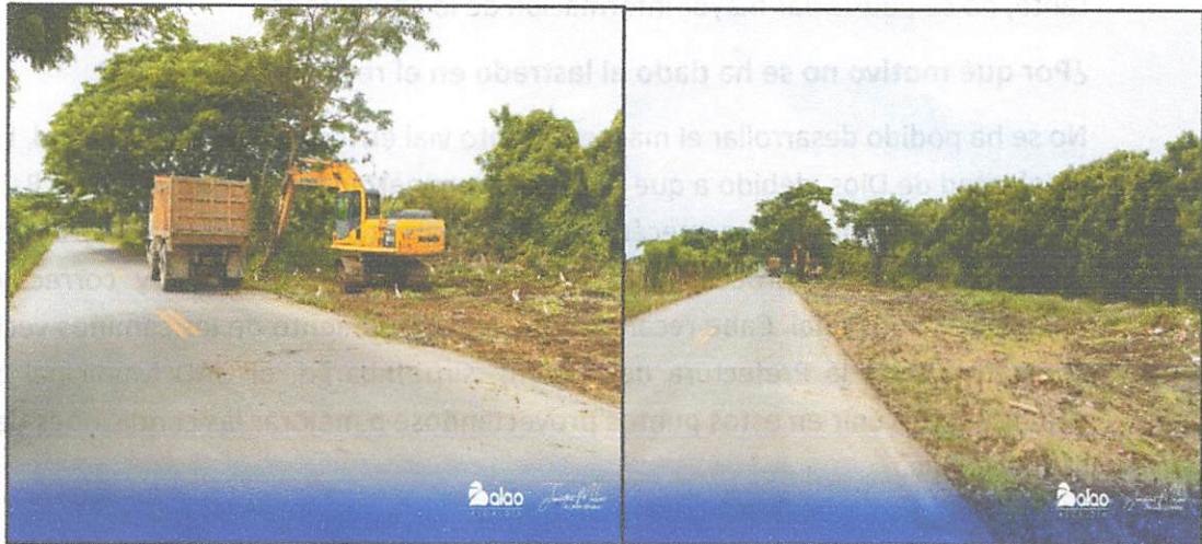
Figura 99 Limpieza de la vía a Puerto Balao
