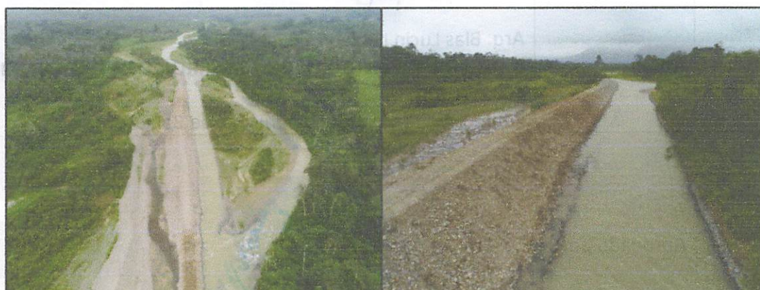
Figura 100 Encausamiento del Río del Rcto. La Libertad
