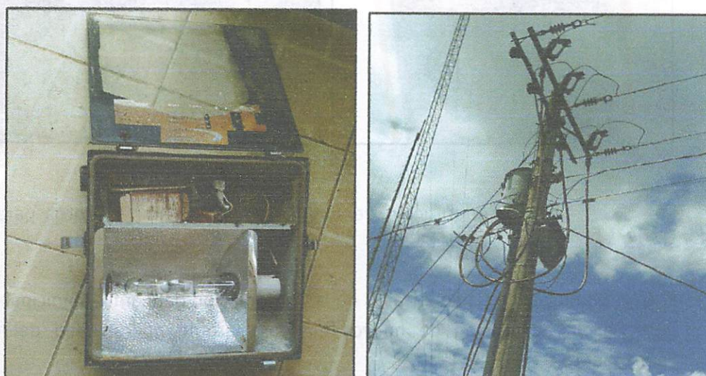
Figura 59 Detalle de actividades de mantenimiento y reparación de luminarias y sistema eléctrico Camal Municipal
