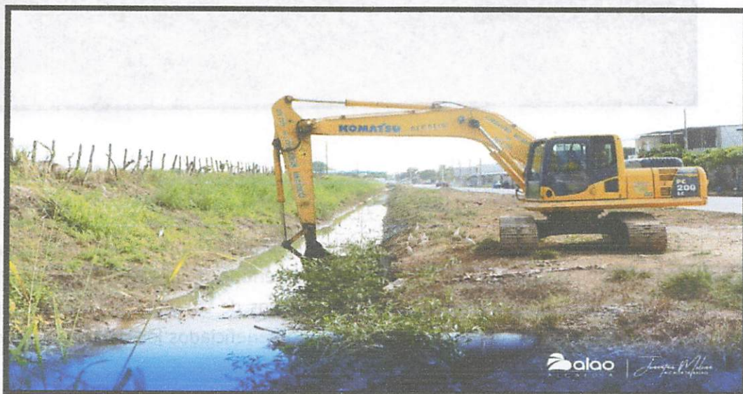
Figura 34 Limpieza del Canal en la Ciudadela Brisas del Mar.
