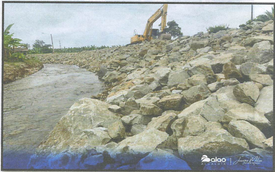
Figura 42 Construcción de muro de escollera en el recinto La Libertad sector Poza del Amor.
