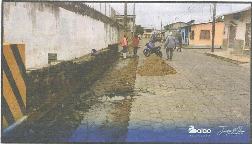
Figura 29 Mantenimiento correctivo de hundimiento de adoquines en la intersección de los sectores Miraflores y 17 de noviembre de la cabecera cantonal.
