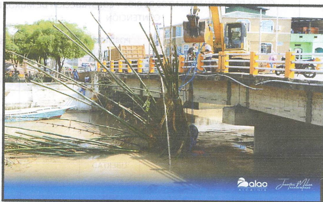
Figura 40 Limpieza de maleza en la base central del puente de ingreso a la cabecera cantonal.
