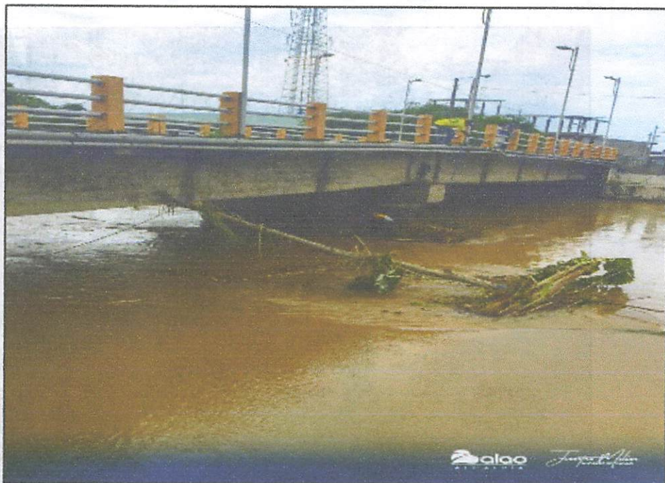
Figura 49 Limpieza de desechos sólidos en el puente
