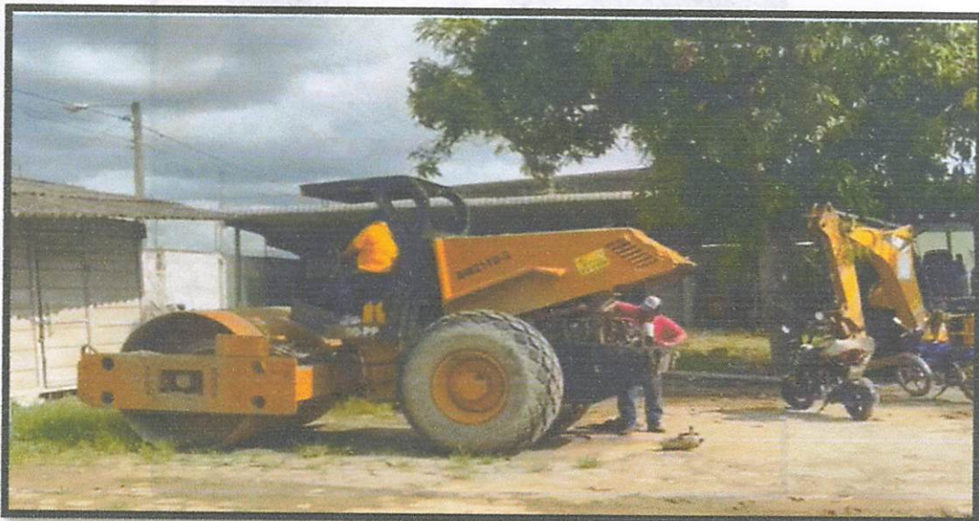
Figura 24 Memoria fotográfica a del mantenimiento de vehículos y maquinarias
