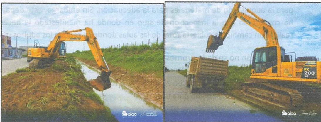
Figura 98 Limpieza de canales de agua lluvia.
