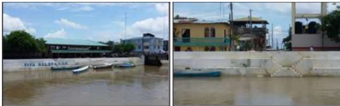
Foto N°2.4.2 Atracaderos en la ciudad de Balao
