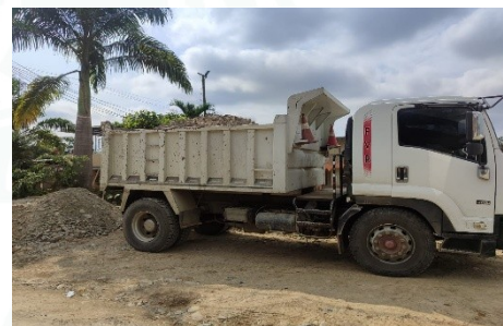
Ilustración 4 Descarga de material
