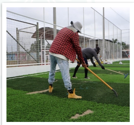
COLOCACION DE ARENA Y PIEDRILLA SINTETICA
