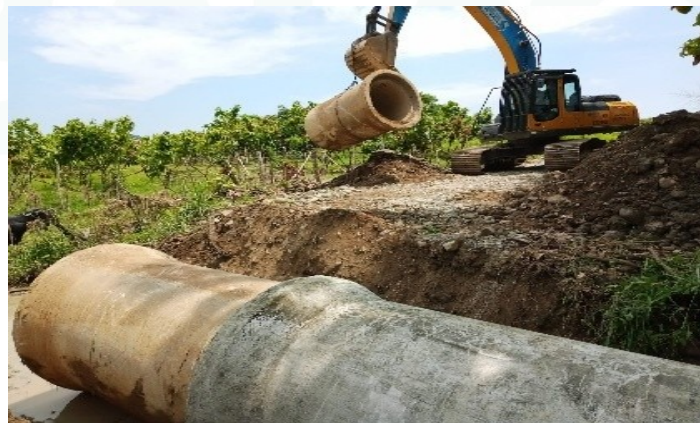
Colocación de ductos cajón en vía a Recinto San Jacinto convenio con prefectura
