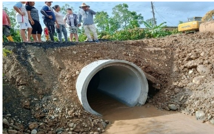
Colocación de tubería de hormigón armado de 48 pulgadas en estero sobre vía a Recinto Pueblo Nuevo
