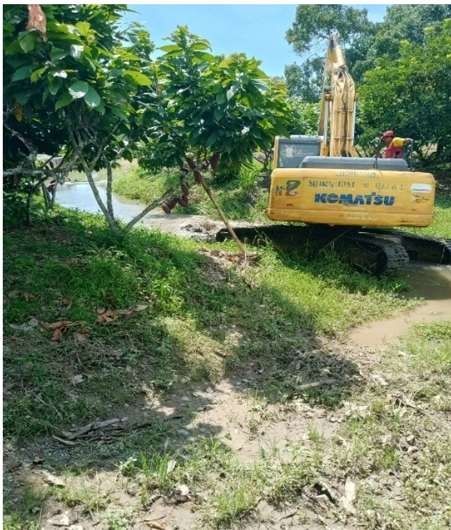
Desazolve de 200 metros en el estero La Joya
