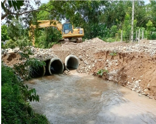
Colocación de tubería de hormigón armado de 48 pulgadas en estero sobre vía a Recinto Pueblo Nuevo
