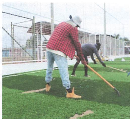
COLOCACION DE ARENA Y PIEDRILLA SINTETICA
