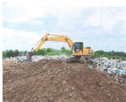
Descarga de material pétreo
