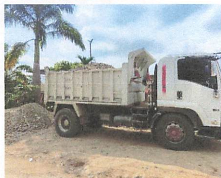
Descarga de Material Pétreo
