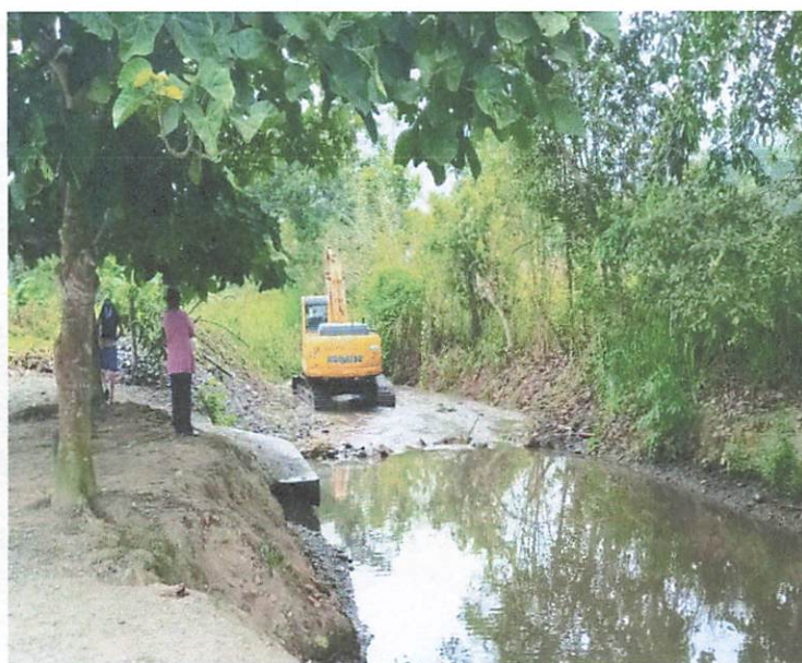
Limpeza estero en sector las violetas de Recinto San Carlos
